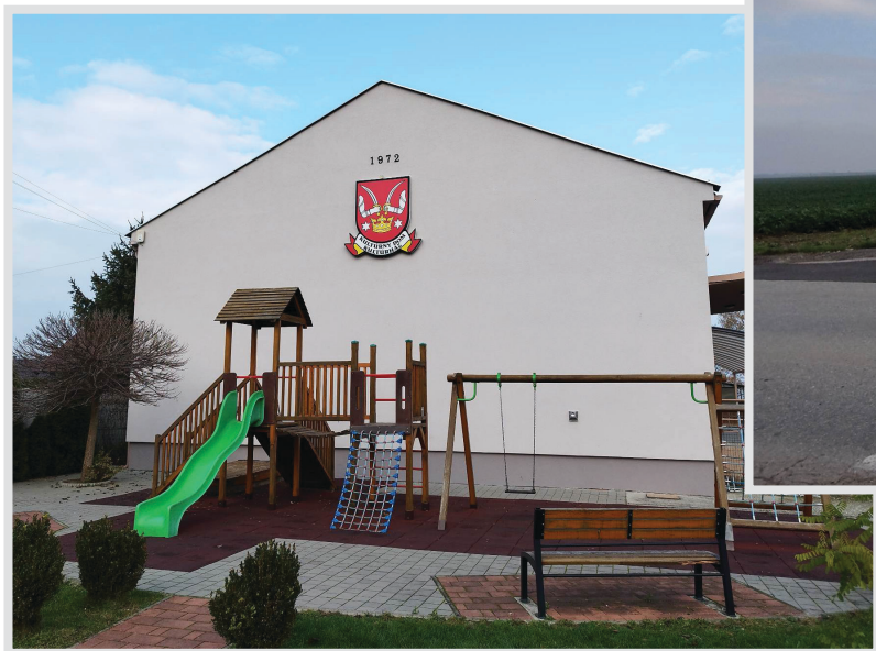
3. Opravená a zateplená predná stena kultúrneho domu A kultúrház előlő falának megjavítása és bemelegítése
