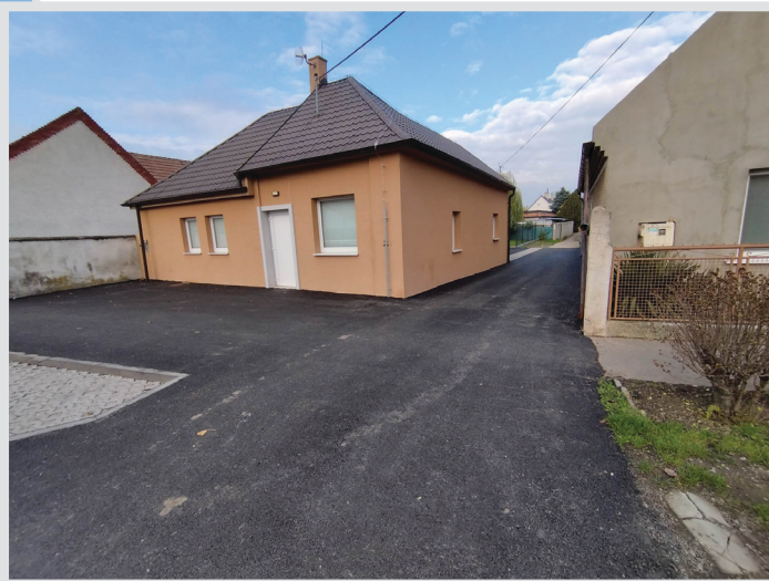
2. Dokončené verejné priestranstvo s odvodom dažďovej vody pred spoločenským domom A közösségi ház előtti köztér kialakítása esővíz elvezetésével
